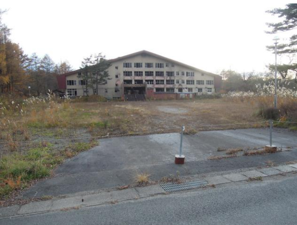
写真1 火災後に放置されている裏磐梯のホテル
