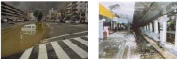
写真3 震災時の大開駅(左: 駅上、右: 駅構内)
