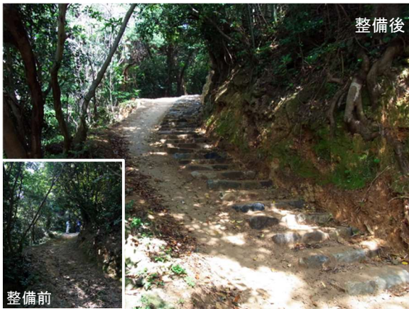
久賀島の景観に配慮した五輪の道の改修
