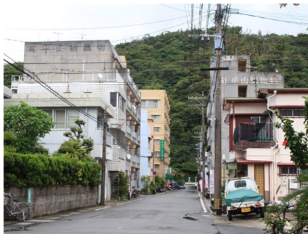
写真1：名瀬の市街地に建つ織工アパート
