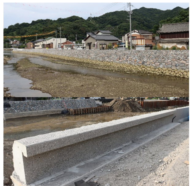
護岸・パラペットの施工状況（2021年8月時点）
