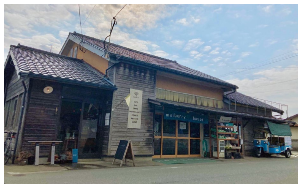
写真3 mulberry house(マルベリーハウス)外観
