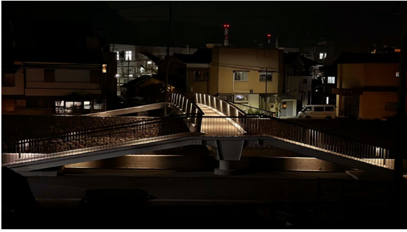
写真4 竣工後の夜間の様子（下岩屋橋周辺）
