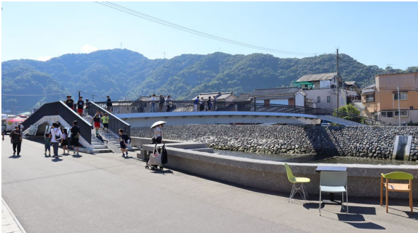
写真5 竣工後の下岩屋橋（竣工記念イベント時の様子）
