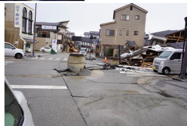
(下左) 液状化による被害 (内灘町)
