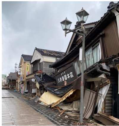
倒壊した家屋が広がる市街地
