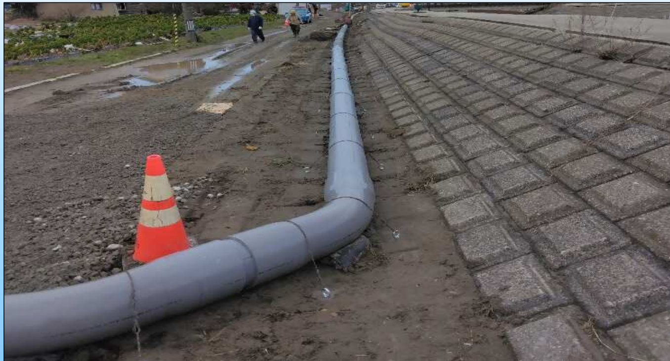
珠洲市浄化センターへ 1.6kmの下水仮設圧送管を布設
