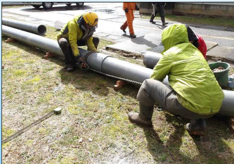
珠洲市浄化センターへ 1.6kmの下水仮設圧送管を布設
