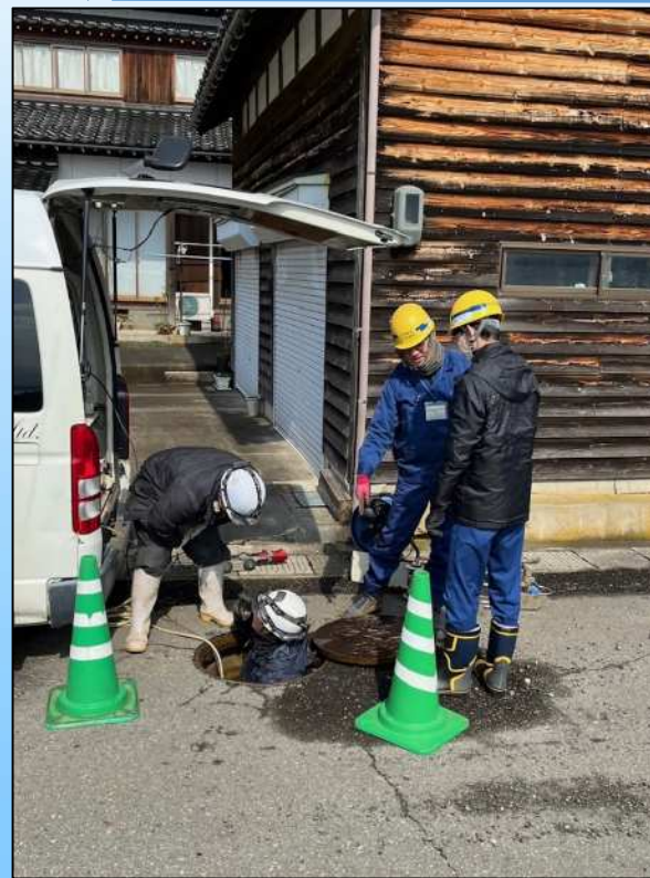
下水本管内 のカメラ調査
