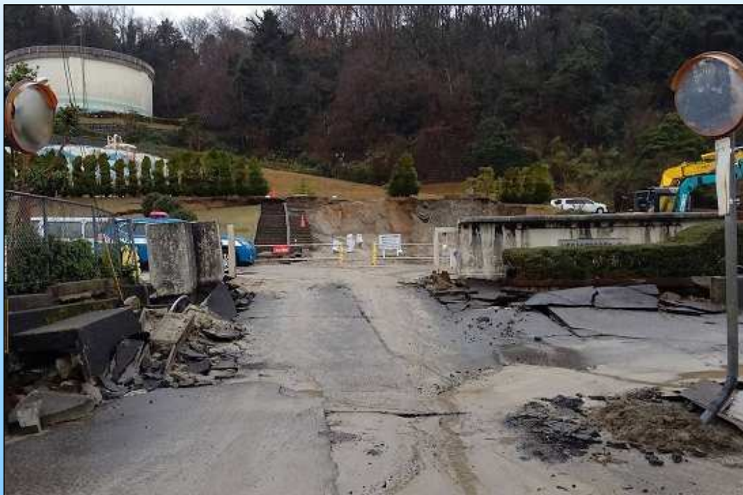
岩屋浄水場入口の外観
