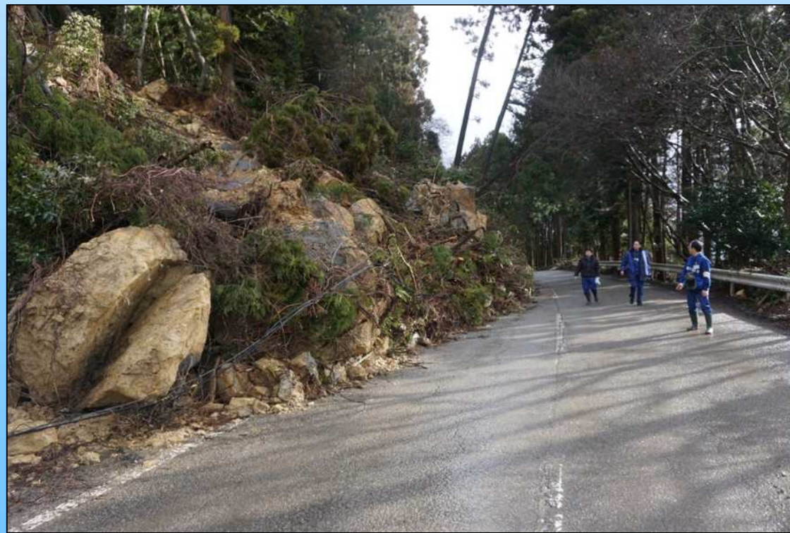
大規模な土砂崩れ
