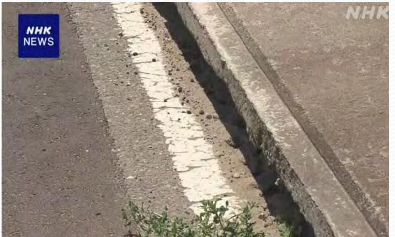
液状化とともに地盤が水平方向に動く「側方流動」
