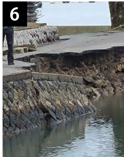
集落に至る道路の護岸が崩落
