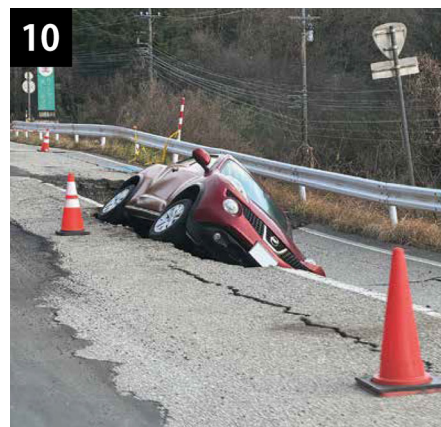
路面が割れ、車が埋まった道路（国道249号、町道）
