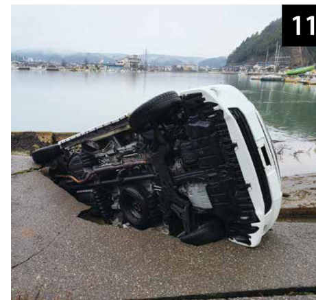
路面が割れ、車が埋まった道路（国道249号、町道）
