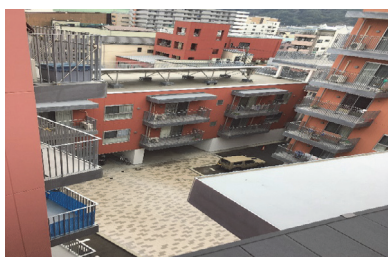
【写真3】 大町復興住宅1号（釜石市）の外観(著者撮影)
