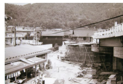
図10 工事中の米原跨線橋(1969年当時)
