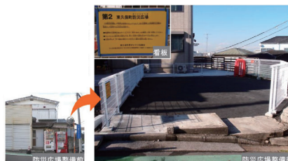
老朽化した空き家を解体して防災広場を整備 / 横浜市ホームページより
