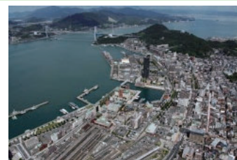
▲福岡県北九州市の門司港レトロ地区では、JR門司港駅をはじめ、点在する歴史的建造物を活用した街並みの形成、ウォーターフロントの整備等が進められた。（写真出典：北九州市HP）
