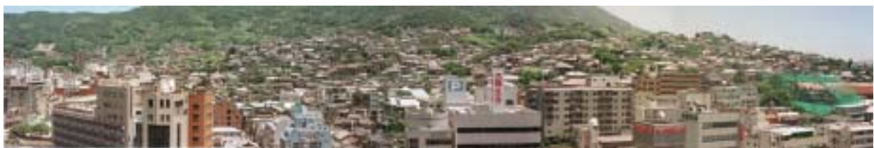
図4 中心市街地の斜面住宅地
