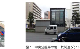
図7 中央分離帯の地下鉄関連ダクト
