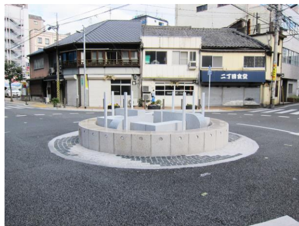
写真2 改修整備後のロータリー
