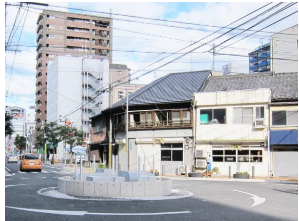
写真3 歩車道境界には縁石と車止めを設置
