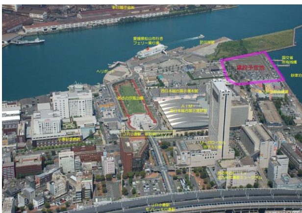
小倉駅新幹線口地区の現況
