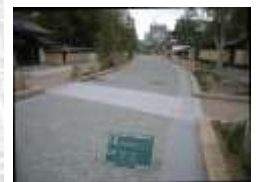
写真4 承天寺通り整備後
